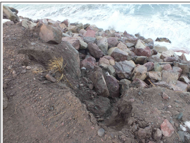
Effondrement sur la zone du parking amont
